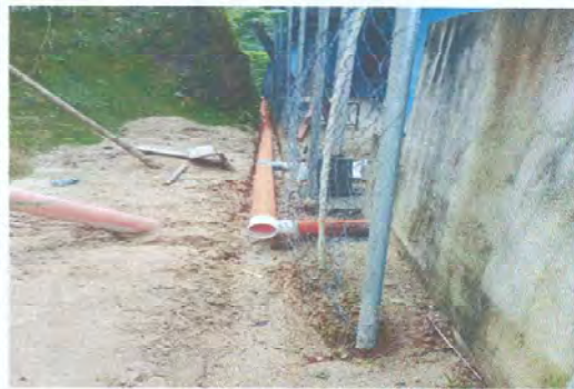
Foto 1: panorama de mejoramiento de agua potable
