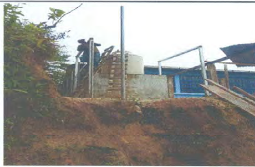
Foto 3: panorama de mejoramiento de agua potable
