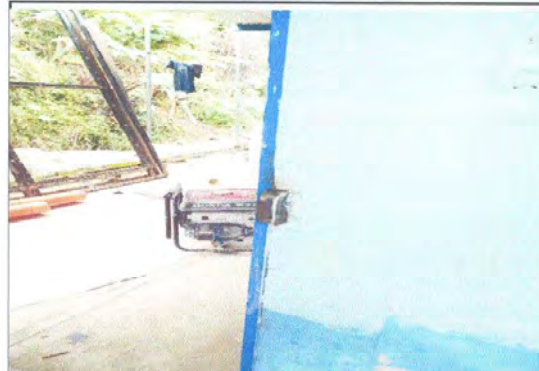
Foto 2: panorama de reparación de puertas
