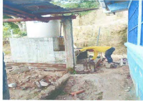
Foto 2: panorama de mejoramiento de agua potable
