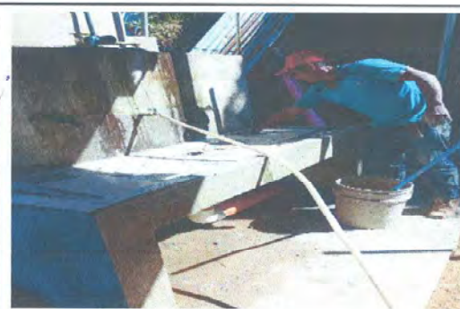
Foto 4: panorama de mejoramiento de agua potable
