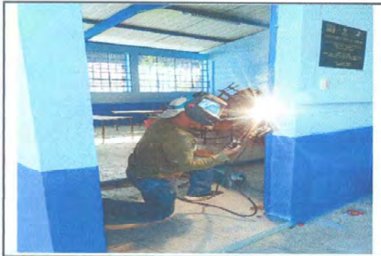
Foto 3: panorama de reparación de puertas
